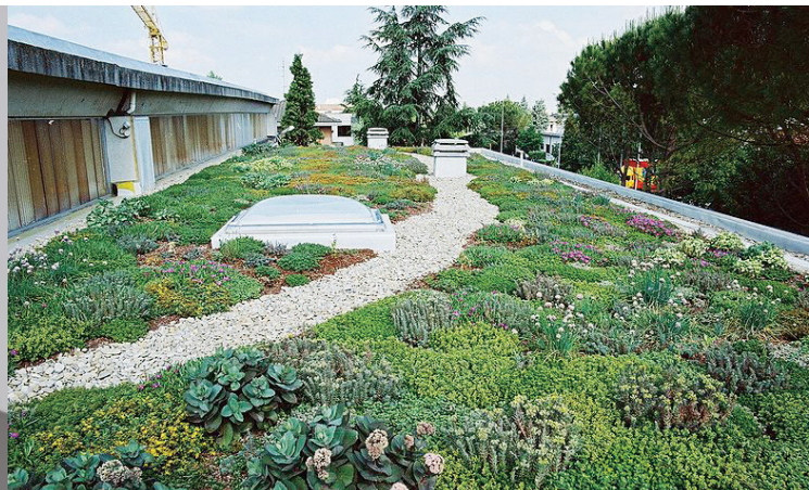
intensiv begrünte Dachfläche
